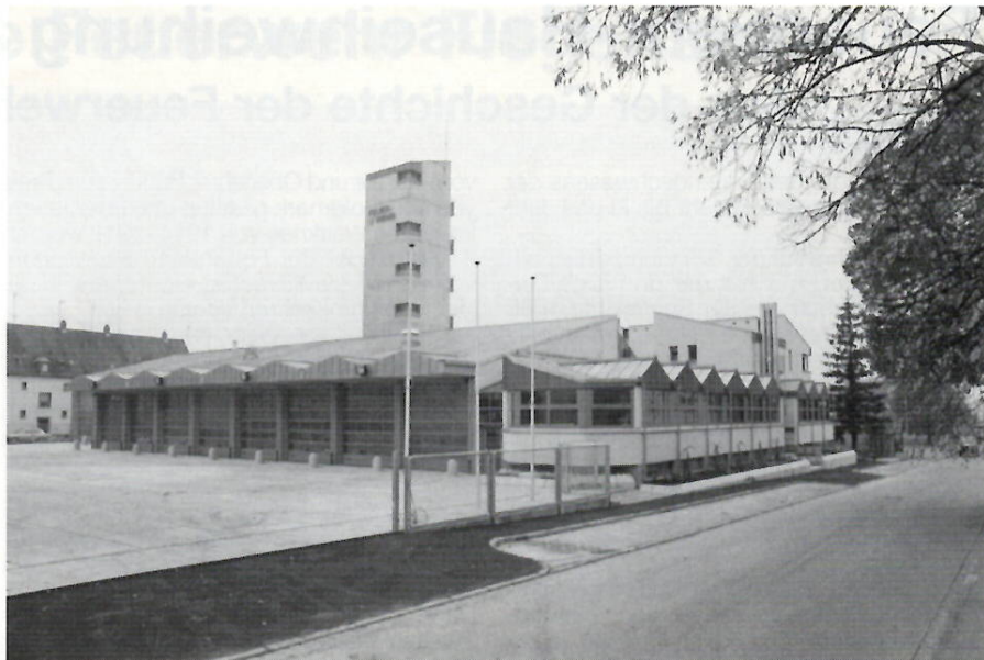
Neues Feuerwehr-Gerätehaus der FF Weißenburg.
